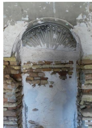
استخدام الحصص لعمل الزخارف في الجدران والطابوق لتشييده.
