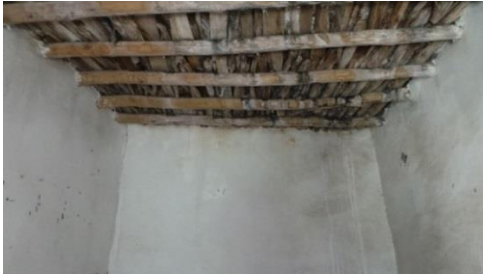
إستخدام الخشب في تشييد السقف.
