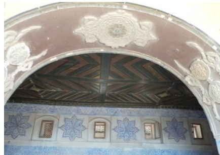
إستخدام الخشب لعمل الزخارف والنقوش في الأقواس والجص لعمل الطاق والزخارف في الجدران .
