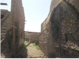
إعادة بناء الجزء الخارجي المنهدم من المسكن.
