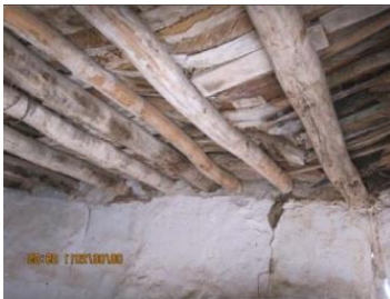
إستخدام الخشب في تشييد السقف.
