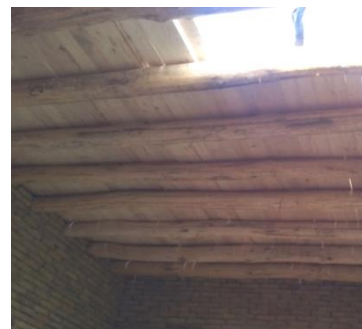
إستخدام الخشب لتشييد السقف والطاق لتشييد الجدران.
