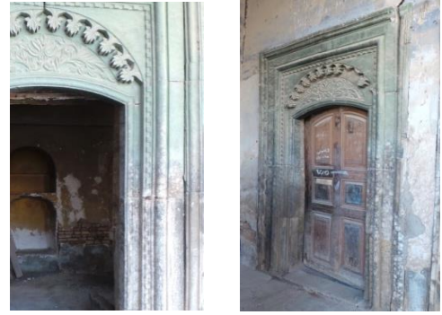
استخدام المرمر لعمل الفتحات والأبواب من الخشب والأقواس المزخرفة بالحصص .
