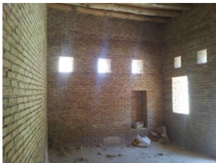
الفتحات الموجودة في المسكن عمل بشكل بسيط وبدون أي تفاصيل معمارية.
