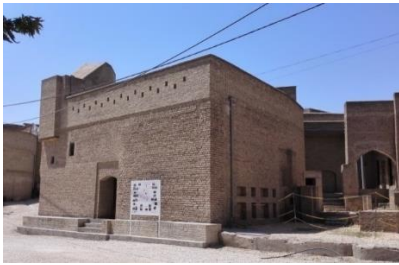
الواجهة الخارجية - الإهتمام بجمالية الواجهة الخارجية عن طريق عمل خسفات في الجدران الخارجية .
