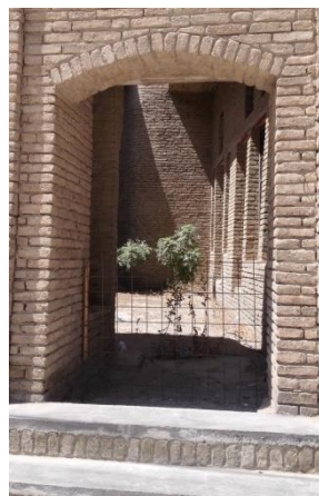
المدخل الرئيسي للمسكن -إستخدام الطابوق لعمل الأقواس فوق الأبواب .
