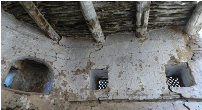
إستخدام الخشب لتشيد السقف والحديد لعمل فتحات التهوية.
