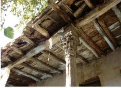
إستخدام الخشب لتشييد السقف وعمل الأعمدة والنقوش.
