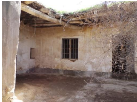
الفناء الداخلي - الفتحات الموجودة في المسكن عمل بشكل بسيط وبدون أي تفاصيل معمارية.
