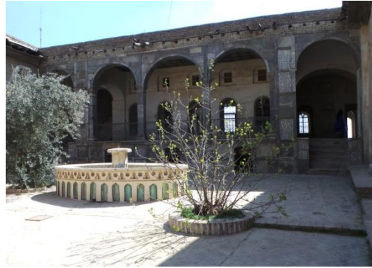
الفناء الداخلي إستخدام المرمر لعمل الأقواس .
