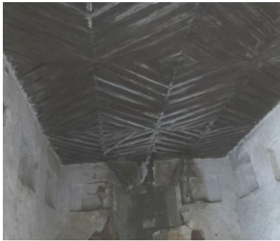
إستخدام الخشب لتشييد السقف وعمل الزخاريف .
