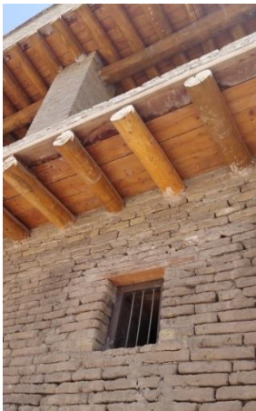
إستخدام الخشب لتشييد السقف والحديد لعمل فتحات التهوية .
