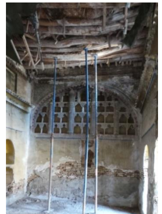
استخدام الحصص لعمل الزخارف في الجدران والطابوق لتشييده.
