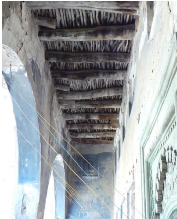
إستخدام الخشب لتشييد السقف .
